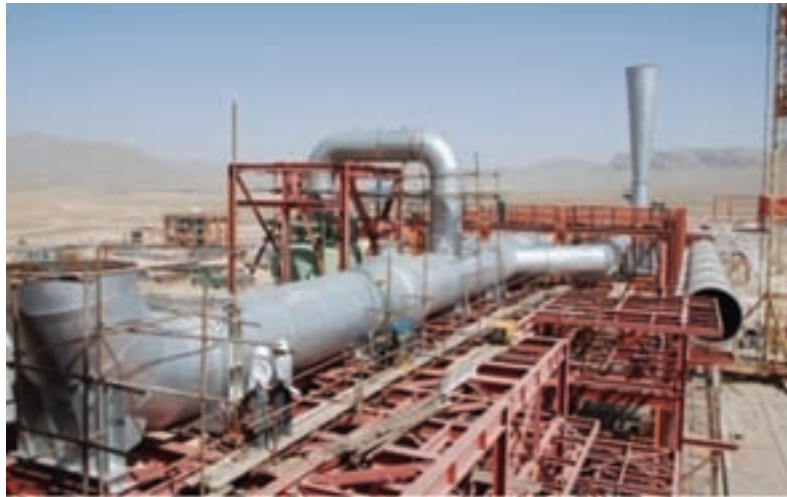
تصویر ۱-۱۵- کارخانه درحال احداث فولاد چهار محال
