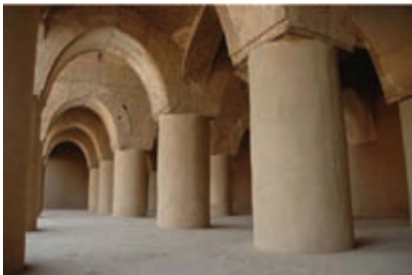
شکل ۱۴-۵ - مسجد تاریخانه در شهر دامغان
