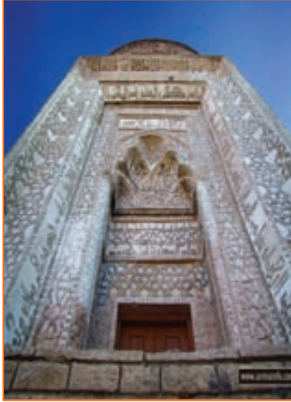
شکل ۲۴-۴- نمایی از سه گنبد ارومیه
