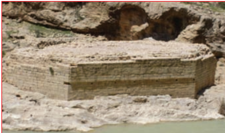
شکل ۳-۴- پایه پل تخت شاه نشین
