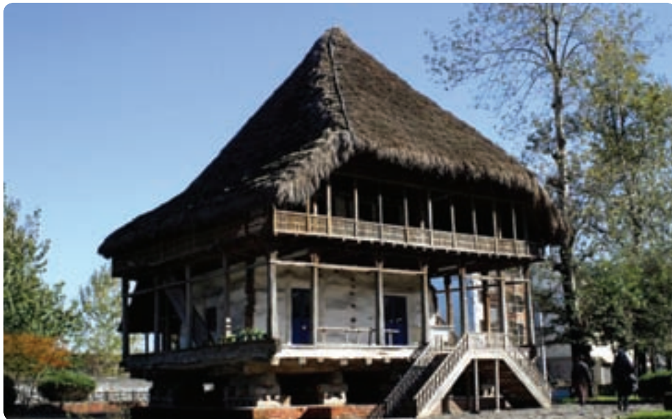
شکل ۶-۲- خانه‌ای با سقف گالی پوش
