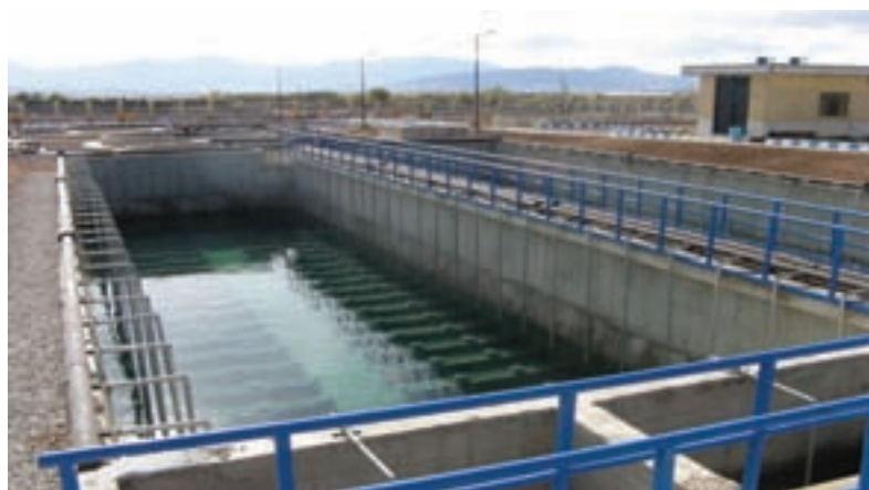
تصویر ۱-۵- تصفیه خانه شهرک صنعتی شهرکرد
