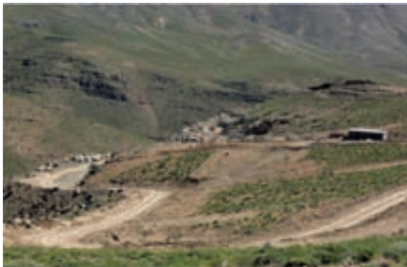
شکل ۲۱-۱- تخریب مراتع در اثر برداشت غیر اصولی از معادن
