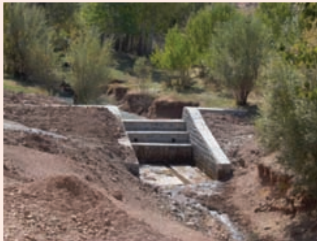
تصویر ۲۰-۲- عملیات آبخیزداری جهت کنترل سیلاب و کاهش فرسایش خاک
