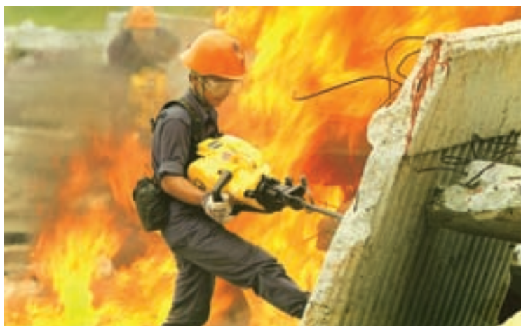
شکل ۱-۷- خرد کردن بتون
