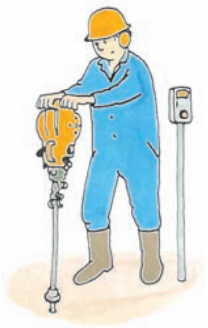
۲- حفاری در بتون و نصب علائم یا پارکومتر...
