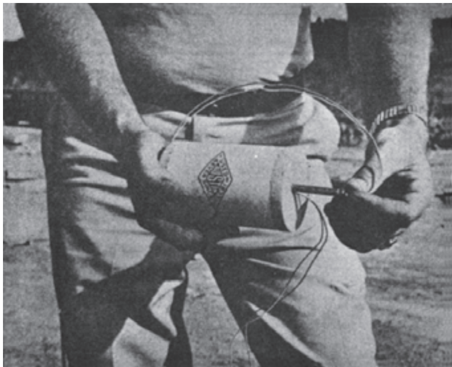
شکل ۸-۱۱ - قرار دادن چاشنی برقی در پرایمر
