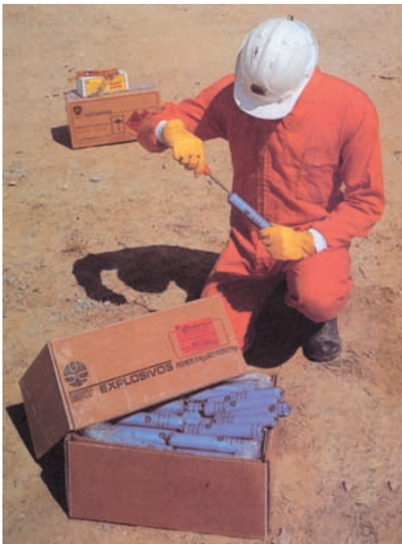
شکل ۷-۱۳- سوراخ کردن دینامیت با درفش
