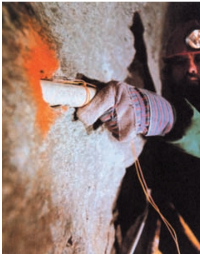
شکل ۴۱-۷- قرار دادن فشنگ چاشنی دار در چال
