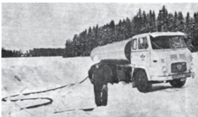
شکل ۱۵-۶- پمپاژ رثولیت به داخل چال
