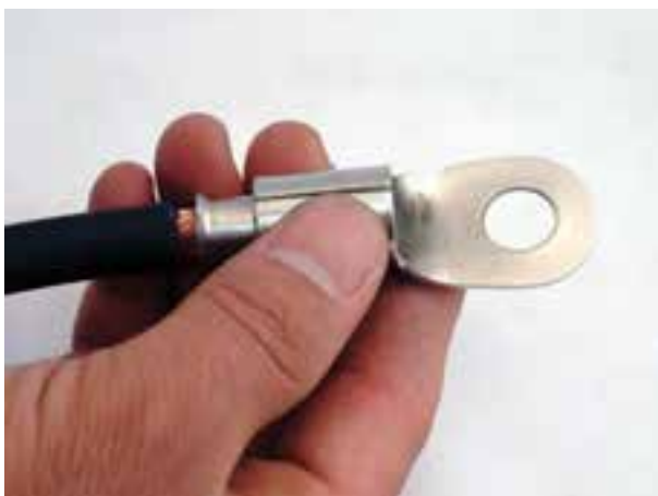
شکل ۱۳-۲- قرار دادن کابل داخل کابل شو
