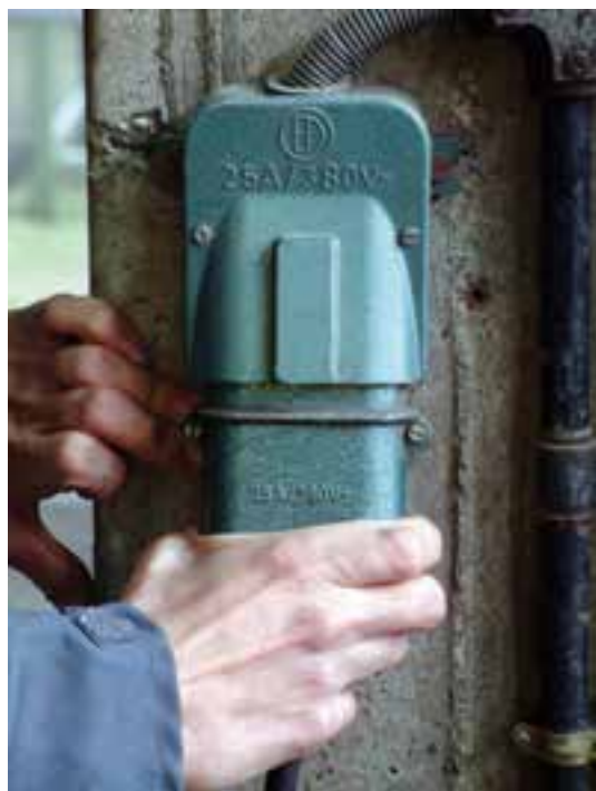
شکل ۱-۳۲- خارج کردن سه شاخه از پریز
