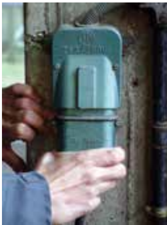
شکل ۵۳-۱- خارج کردن سه شاخه از برق
